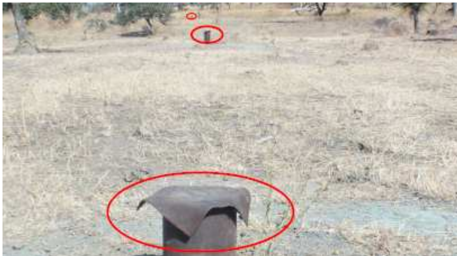
Photo P3 : nombreux points de forage dans le secteur de TEUBANG (photo de janvier 2014)
